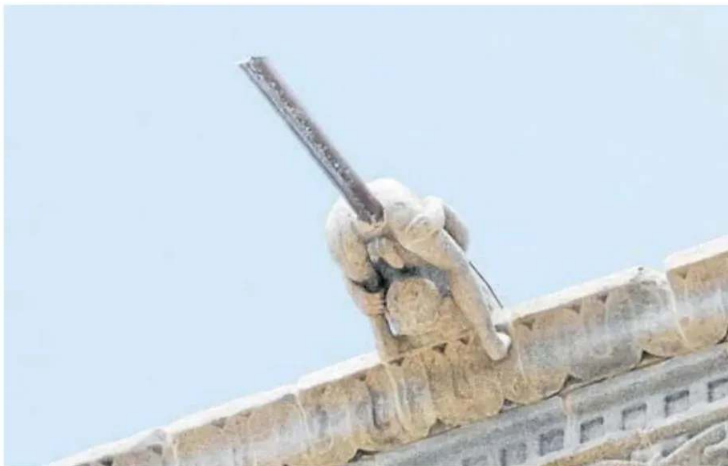
La única gárgola antropomórfica de la fachada del Parador, tras la intervención. Miguel Muñiz
